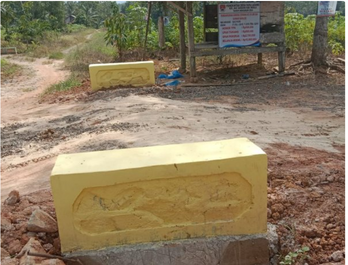
Pembangunan gorong-gorong Desa Suka Agung
